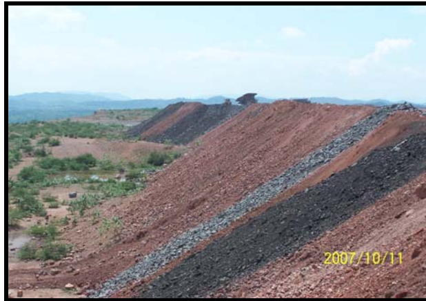
Fig. 66: Exposición de estéril carbonoso en taludes finales Fuente: Superintendencia de Ingeniería de CDG
