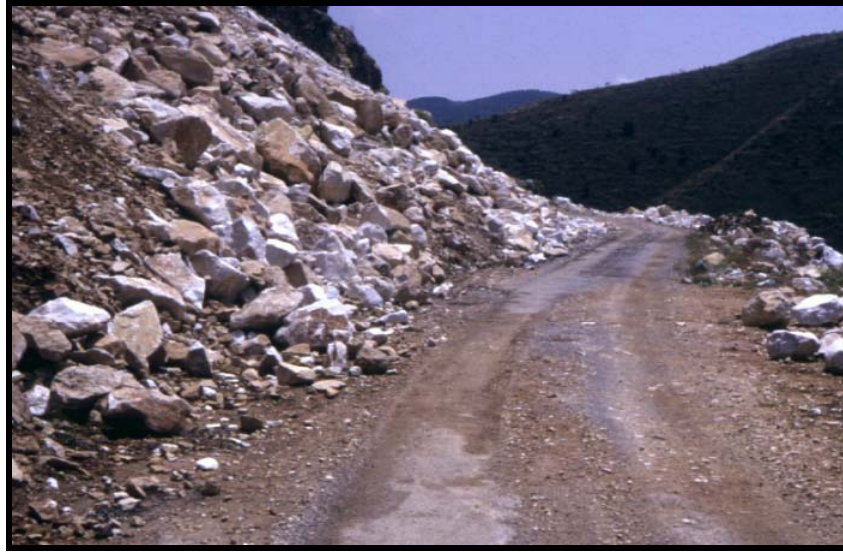
Fig. 5: Heterogeneidad granulométrica de los estériles en una escombrera
