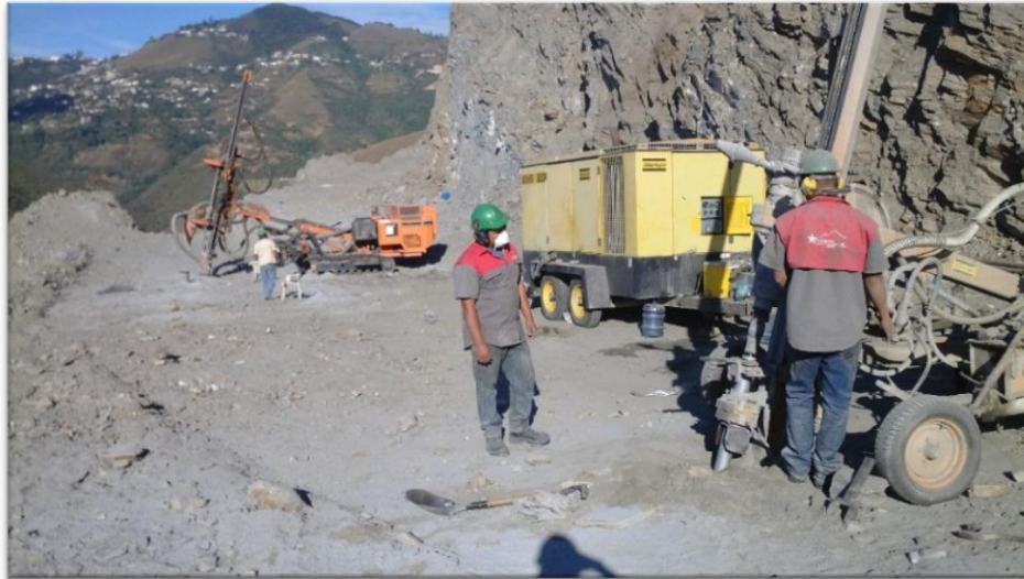
Figura. 40. Perforadora Atlas Copco con martillo de fondo. Fuente: Propia (2014).
