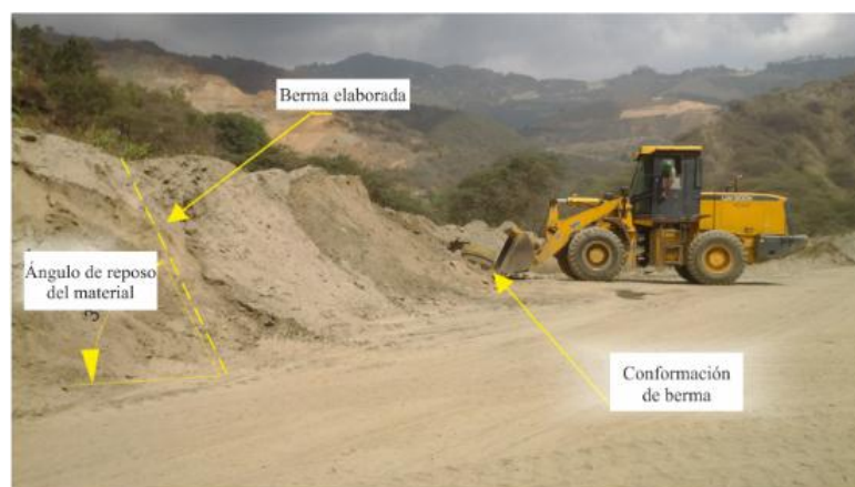
Figura. 53. Conformación de bermas. Fuente: Propia (2015).
