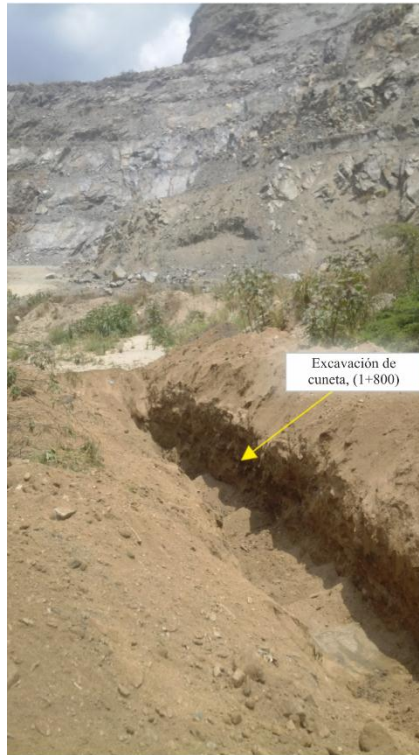
Figura. 64. Realización de cuneta (Tramo 01). Fuente: Propia (2015).
