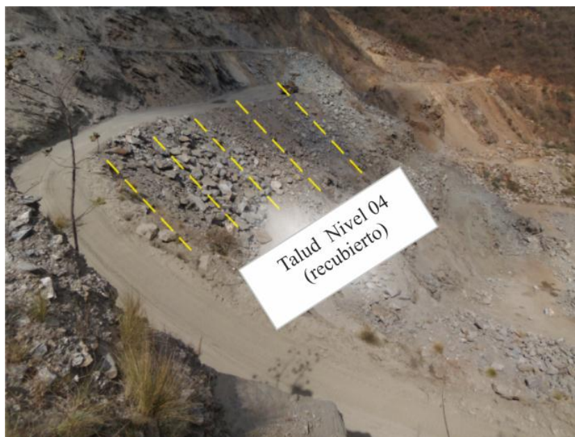
Figura. 67. Talud recubierto por material sobretamaños. Fuente: Propia (2015).
