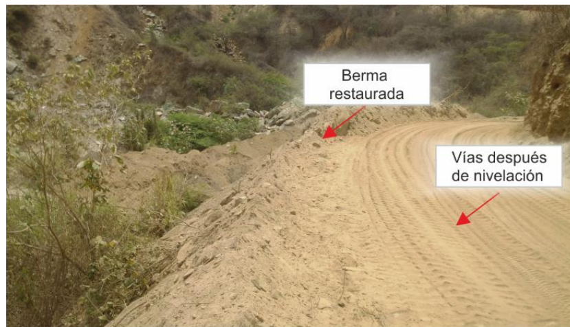
Figura. 56. Nivelación de vía y conformación de berma (Tramo 02). Fuente: Propia (2015).
