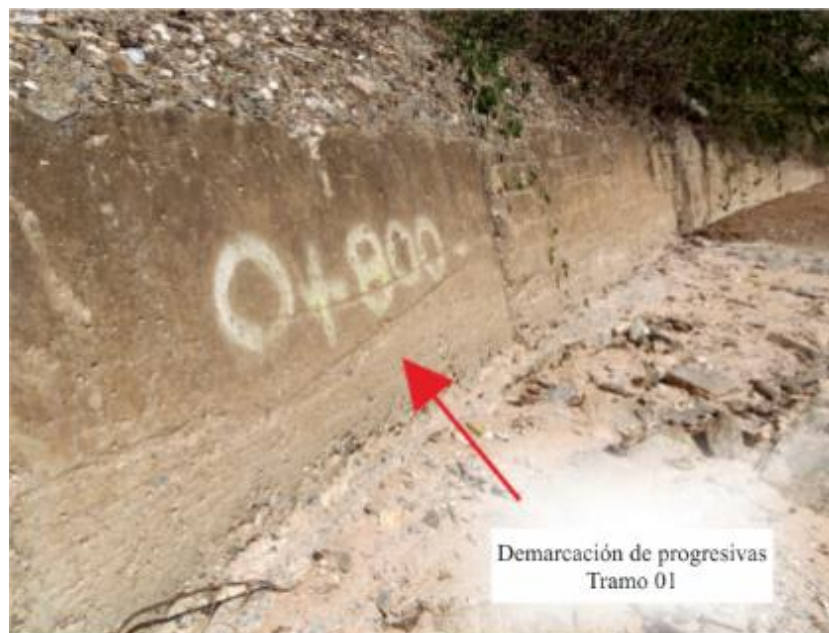
Figura. 52. Demarcación de progresivas (Tramo 01). Fuente: Propia (2015).
