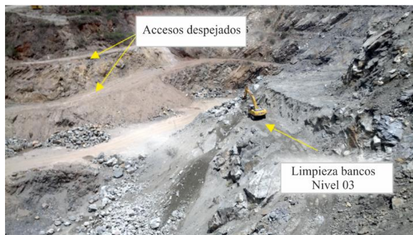
Figura. 72. Despeje de bancos, Nivel 02 y 03, (Bloques 3 y 4). Fuente: Propia (2015).
