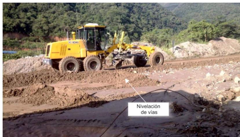
Figura. 57. Nivelación de vías (Tramo 01). Fuente: Propia (2015).
