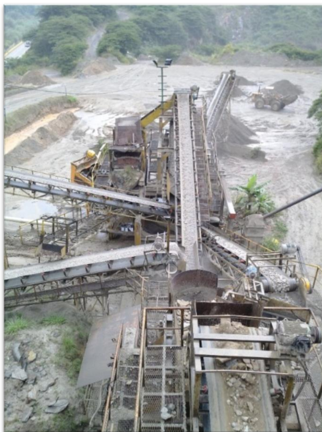
Figura. 42. Perfil visual de Planta III. Fuente: propia (2014).
