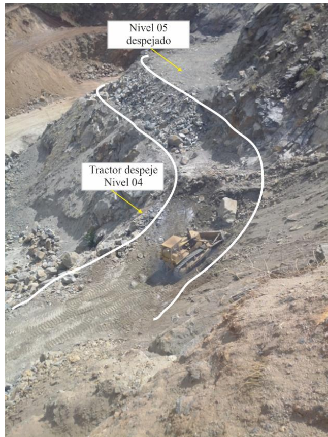
Figura. 71. Empuje de material sobre las paredes del talud, Nivel 03. (Bloque 2) Fuente: Propia (2015).
