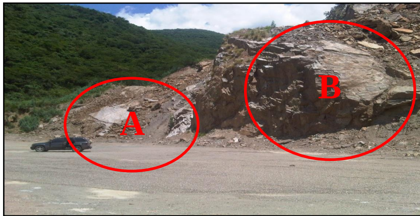
Figura N° 8. A) Esquistos grafitosos - granatíferos, Cuarzo calcáreos. B) Mármol compacto en parte sur del frente 4 (base de la frecuencia litoestratigráfica expuesta). Fuente: Informe Cantera Carayaca VARCAM C.A (2015)
