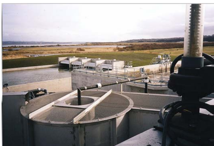
Figura 3: Planta de tratamiento de aguas residuales con sistema SBR.
