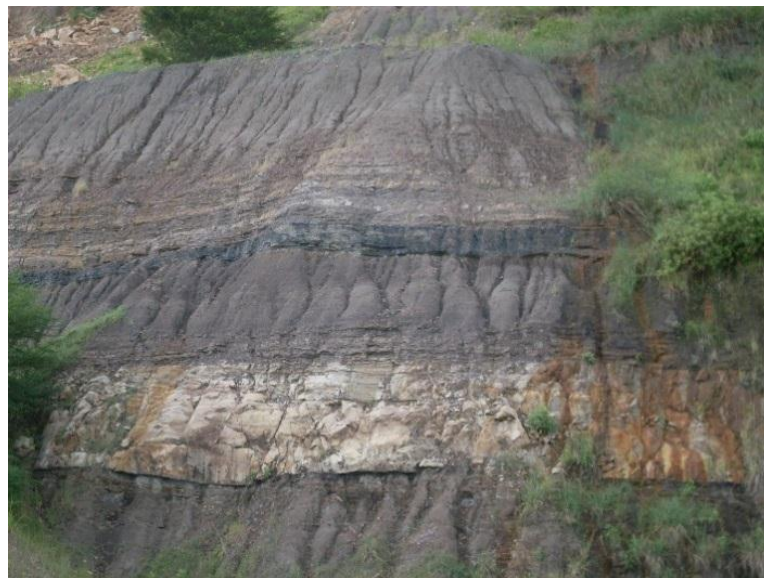
Figura 10. Talud de la mina en Fila Maestra.
