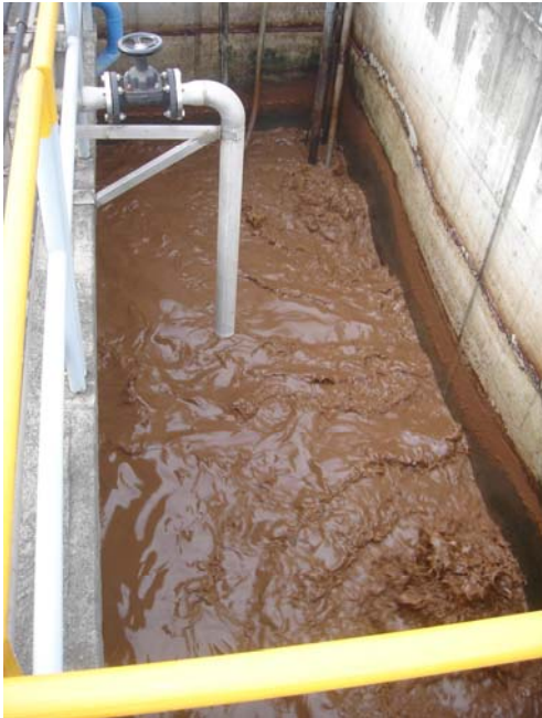
Figura A-5. Digestor Biológico, que opera en Productos EFE, S.A.
