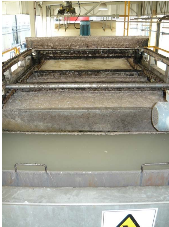
Figura A-3. Sistema de Flotación (CAF), que opera en Productos EFE, S.A.
