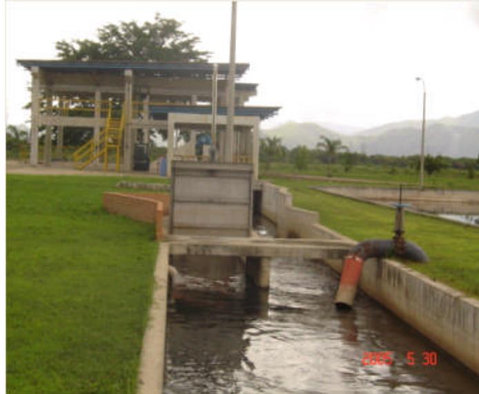
Figura 4: Llegada de las aguas servidas a la planta
