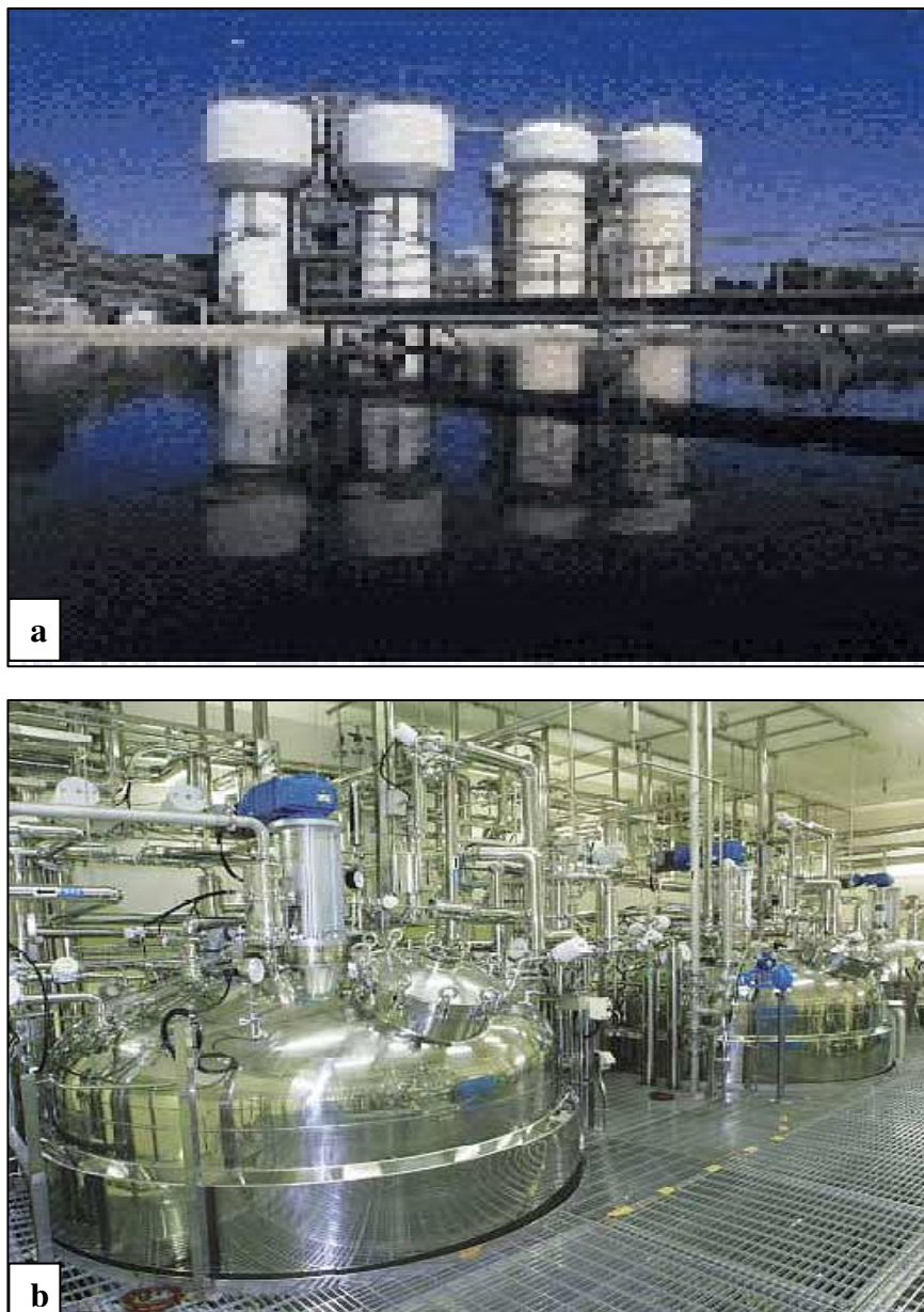
Figura N° 12 (a) Biorreactores enzimáticos para la degradación de vertidos industriales contaminados con fenoles. (b) biorreactores utilizados para cultivo de bacterias en el proceso de Fermentación.
