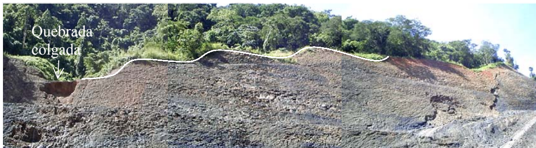
Fig. 28. Morfología del talud ubicado entre las progresivas 3+300 a la 3+500. Nótese la forma de escalones típico de paleodeslizamientos que ocurrieron hacia la quebrada colgada ubicada hacia la izquierda.
