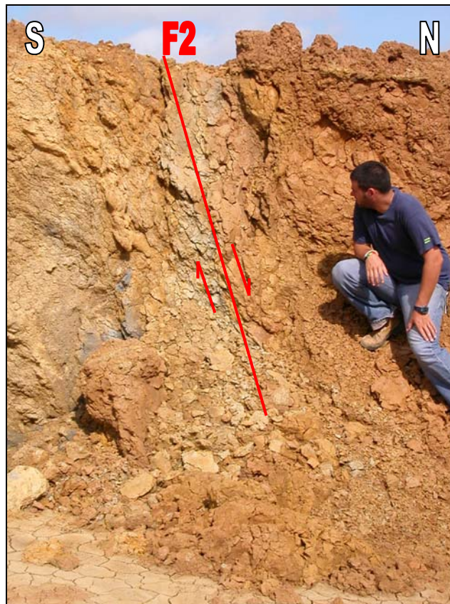
Fig. 36 Traza de la falla F2 en el sector de la actual cantera de arcilla (componente normal).
