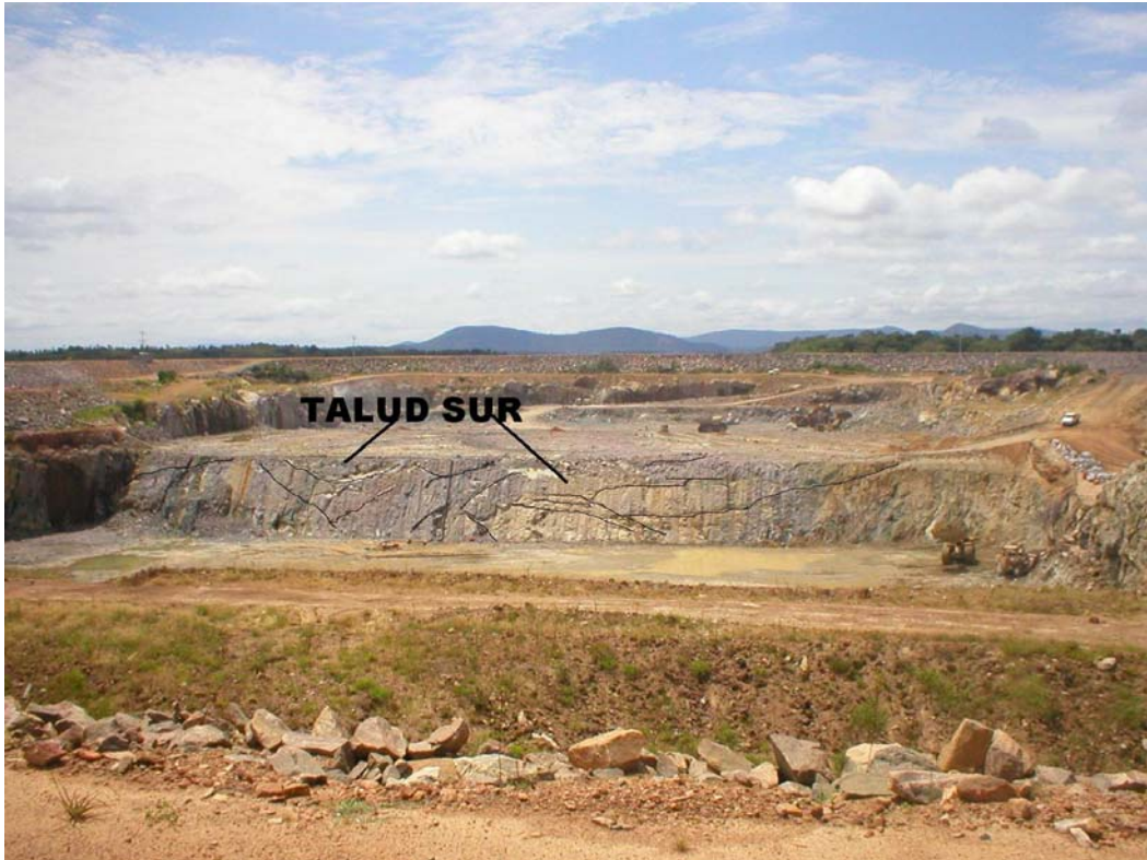
Figura 6.1 Talud sur del pozo disipador del aliviadero
