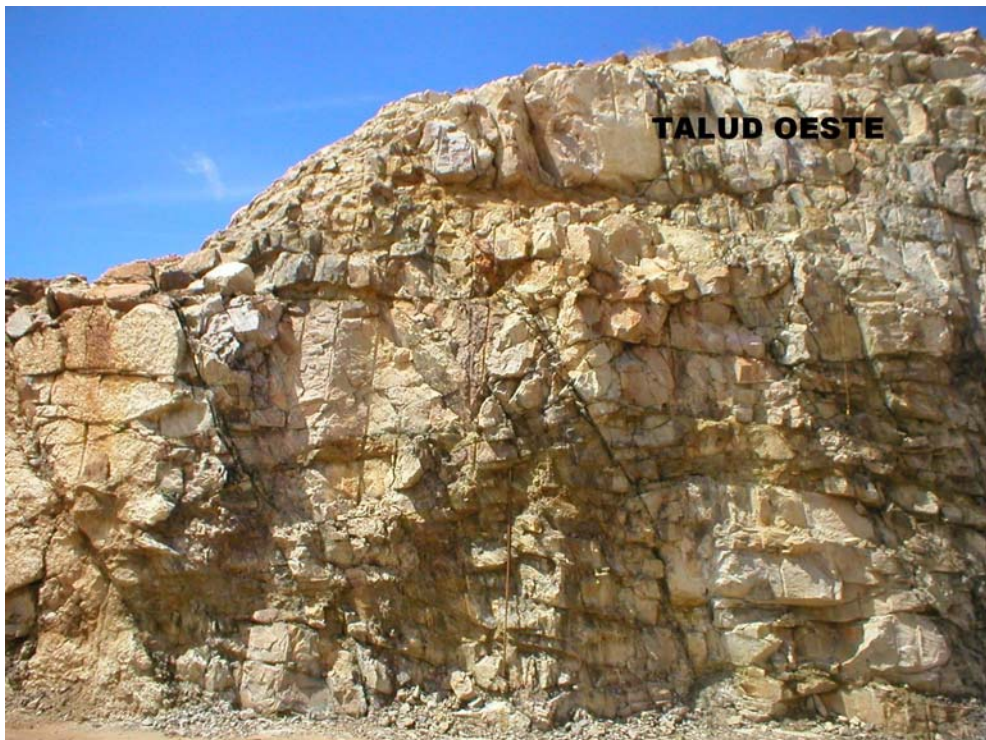
Figura 6.2 Talud oeste del pozo disipador del aliviadero
