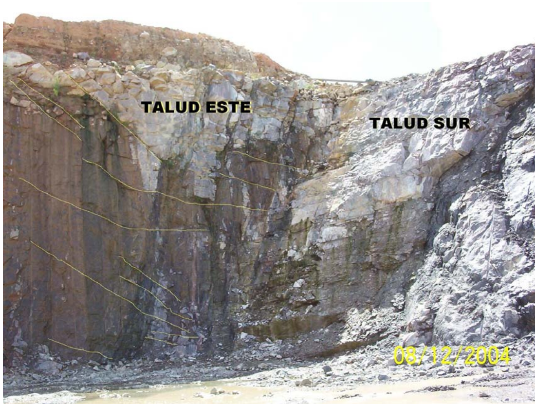
Figura 6.3 Talud este del pozo disipador del aliviadero
