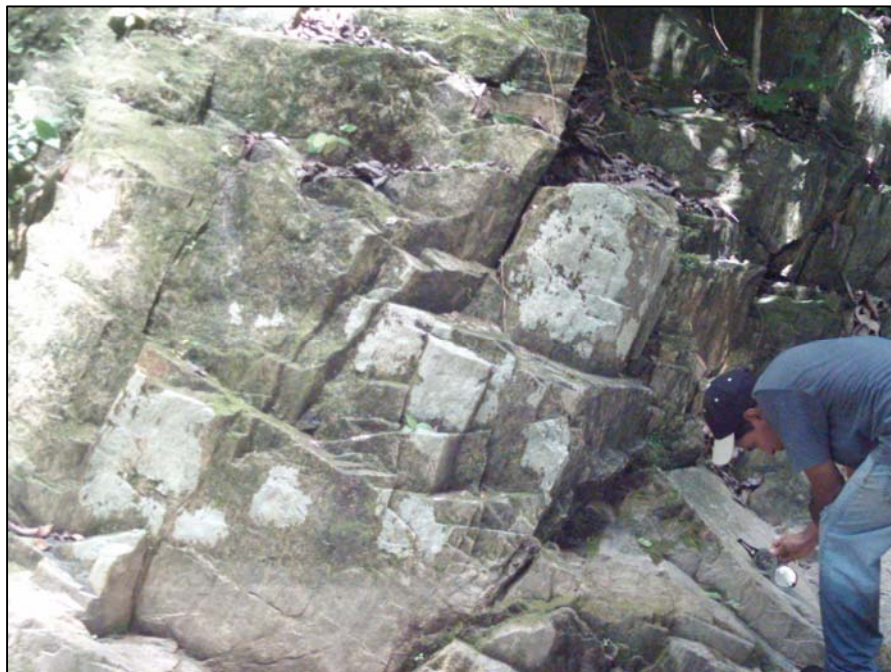
Figura 108: Diaclasado presente en la quebrada Charallave. Foto tomada con rumbo N65^{\circ}W .
