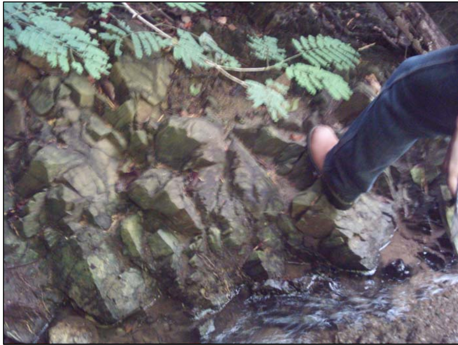
Figura 118: Diaclasado presente en el área norte de Charallave. Foto tomada en la quebrada La Aguadita con rumbo N15°E.
