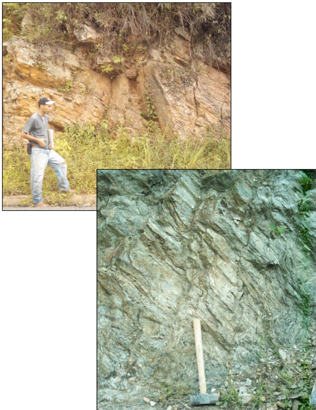
Figura 104: Diaclasado presente en el área norte de Paracotos. Arriba: Foto tomada en la localidad de Los Lirios con rumbo N63°E. Abajo: Foto tomada en la autopista Caracas-Valencia con rumbo N5°W.
