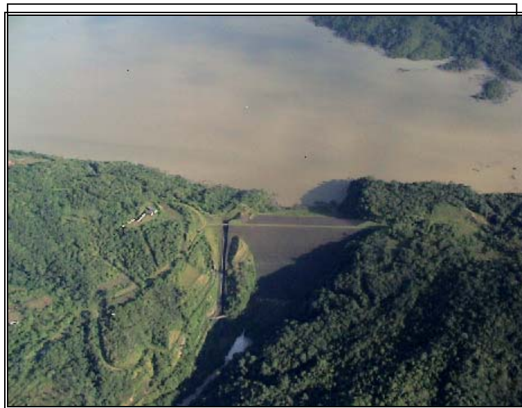
Figura 2.4 Fotografía Aérea de la presa Borde Seco.
