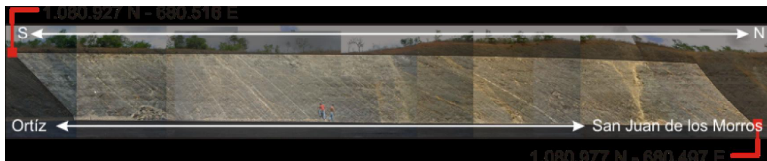
Foto 7. Se observa el paquete # 2 dentro del afloramiento # 4, con sus respectivas coordenadas de inicio-final y el sentido referencial San Juan de los Morros-Ortíz.
