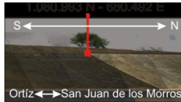
Foto 10. Se observa el paquete # 5 dentro del afloramiento # 4, con sus respectivas coordenadas de inicio-final y el sentido referencial San Juan de los Morros-Ortíz.
