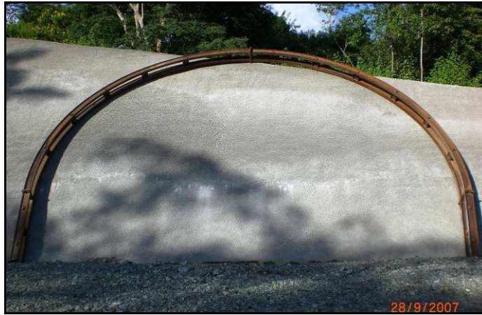
Foto 20. Cercha utilizada en el túnel San Juan, radio de 5 metros
