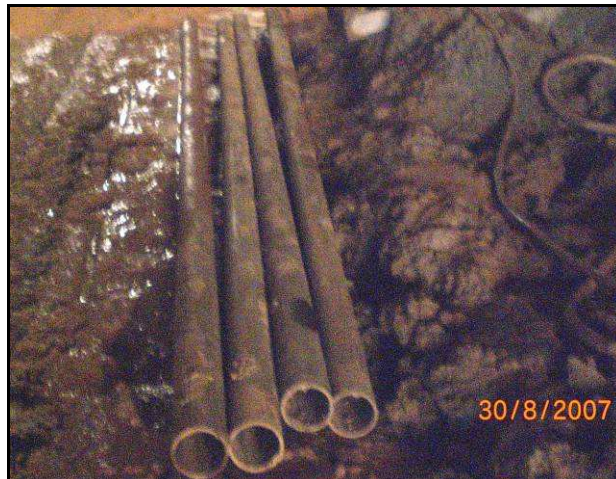
Foto 23. Micropilotes utilizados en el túnel San Juan. Foto por: Luís Zurbarán
