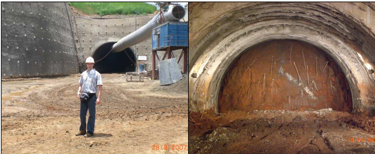
Foto16. Túnel San Juan, Portal norte. Sistema ferroviario, San Juan de los Morros – San Fernando de Apure, progresiva 2+235 Foto por: Luis Zurbarán
