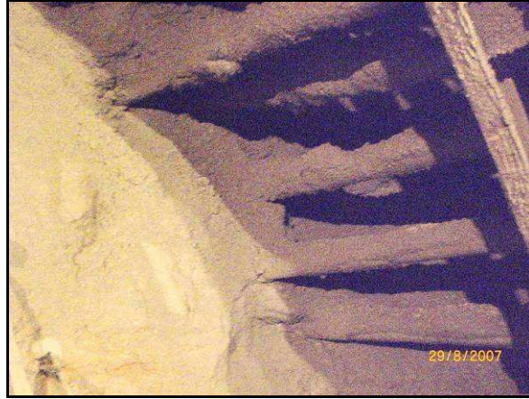
Foto 24. Micropilotes alrededor de la clave del túnel San Juan formando un paraguas Foto: Luís Zurbarán.
