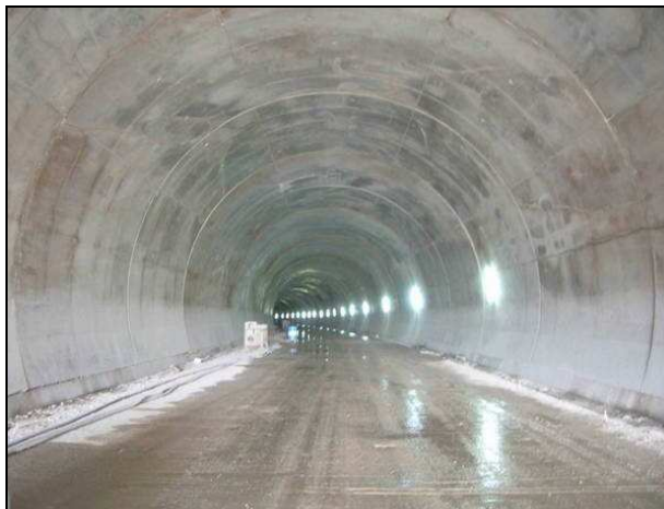
Foto 25. Revestimiento de concreto. Túnel de piqueras, España.
