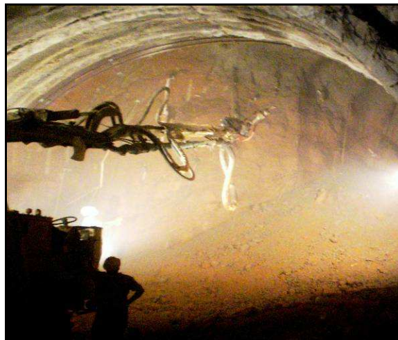
Foto 21. Aplicación del concreto proyectado en el túnel San Juan
