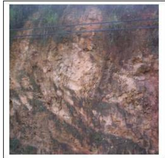
Foto 18. Talud 08. Metaareniscas, rocas de color marrón claro.
