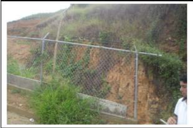
Foto 11. Talud 13. Metaconglomerado (izquierda). Detalle, granos de cuarzo sin orientación preferencial, familia de diaclasas en el rectángulo (derecha).
