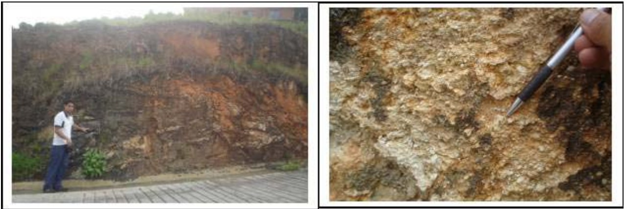
Foto 10. Talud 16. Metaconglomerado (izquierda). Detalle, granos de cuarzo sin orientación preferencial (derecha).
