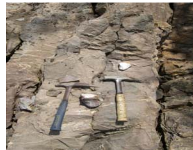
Fig. B14. Contacto entre capas de arenisca que presentan distintos niveles de meteorización.
