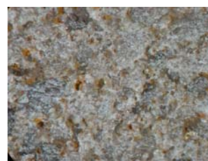
Fig. B8. Obsérvese la coloración rojiza producto de la meteorización.
