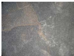
Fig. B68. Obsérvese la coloración rojiza producto de la meteorización de las rocas en contacto.
