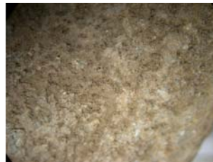
Fig. B11. Nótese la alta meteorización que presenta la arenisca.
