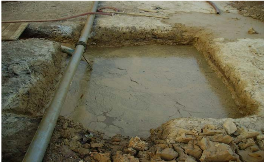
Figura 13: Depósito para la circulación del fluido durante la perforación
