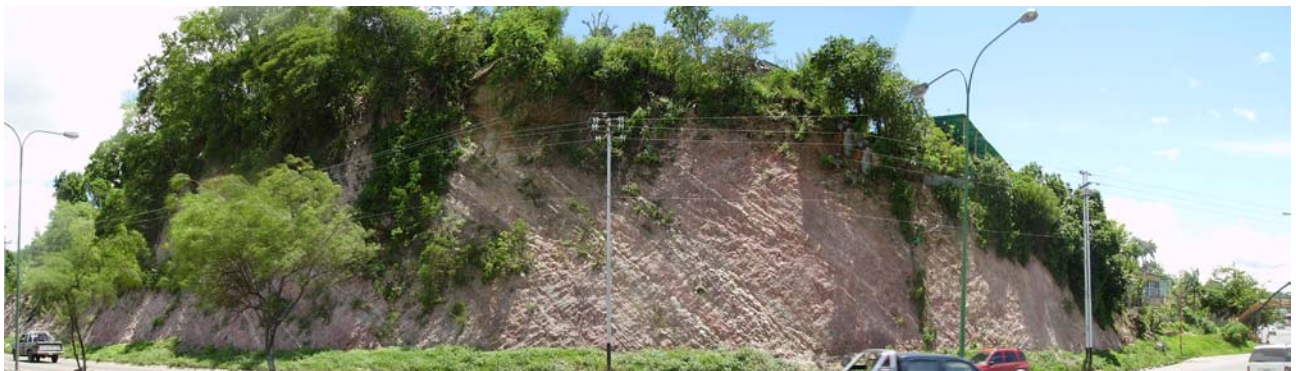
Figura 8: Fotomosaico en detalle de las unidades Cretácicas, formación Barquisimeto, donde se muestra el contacto discordante con las unidades cuaternarias, ubicado a lo largo de avenida Nectario Maria (Rivereña), sector Puente Macuto, al sur de la ciudad de Barquisimeto y el río Turbio
