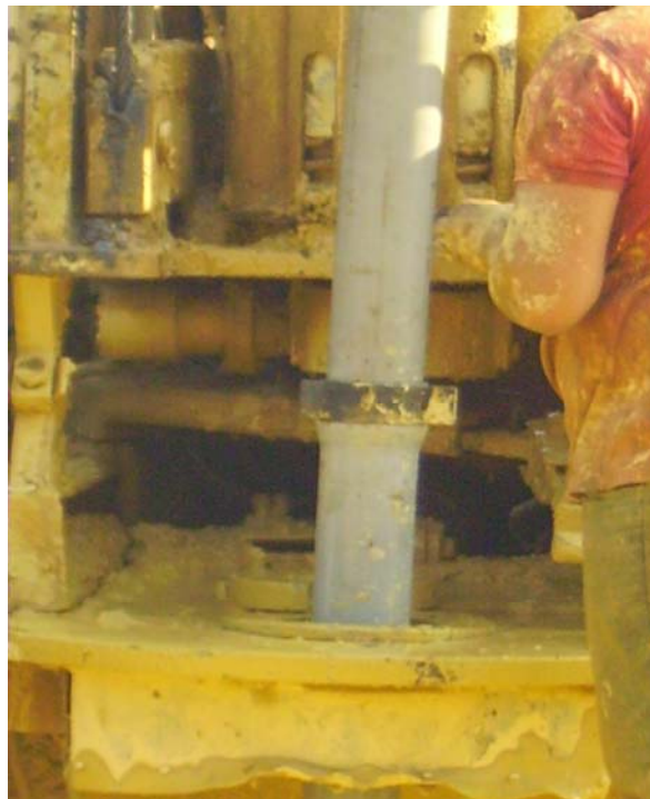
Figura 15: Detalle de colocación del centralizador.
