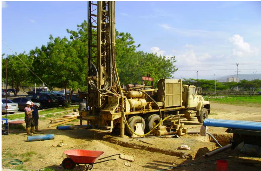
Figura 3: Vista hacia el sur del área en estudio, ejecución de la perforación del Pozo P-2
