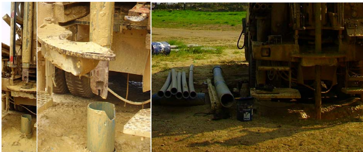
Figura 12: Vista del sistema de sobrepeso en la mecha
