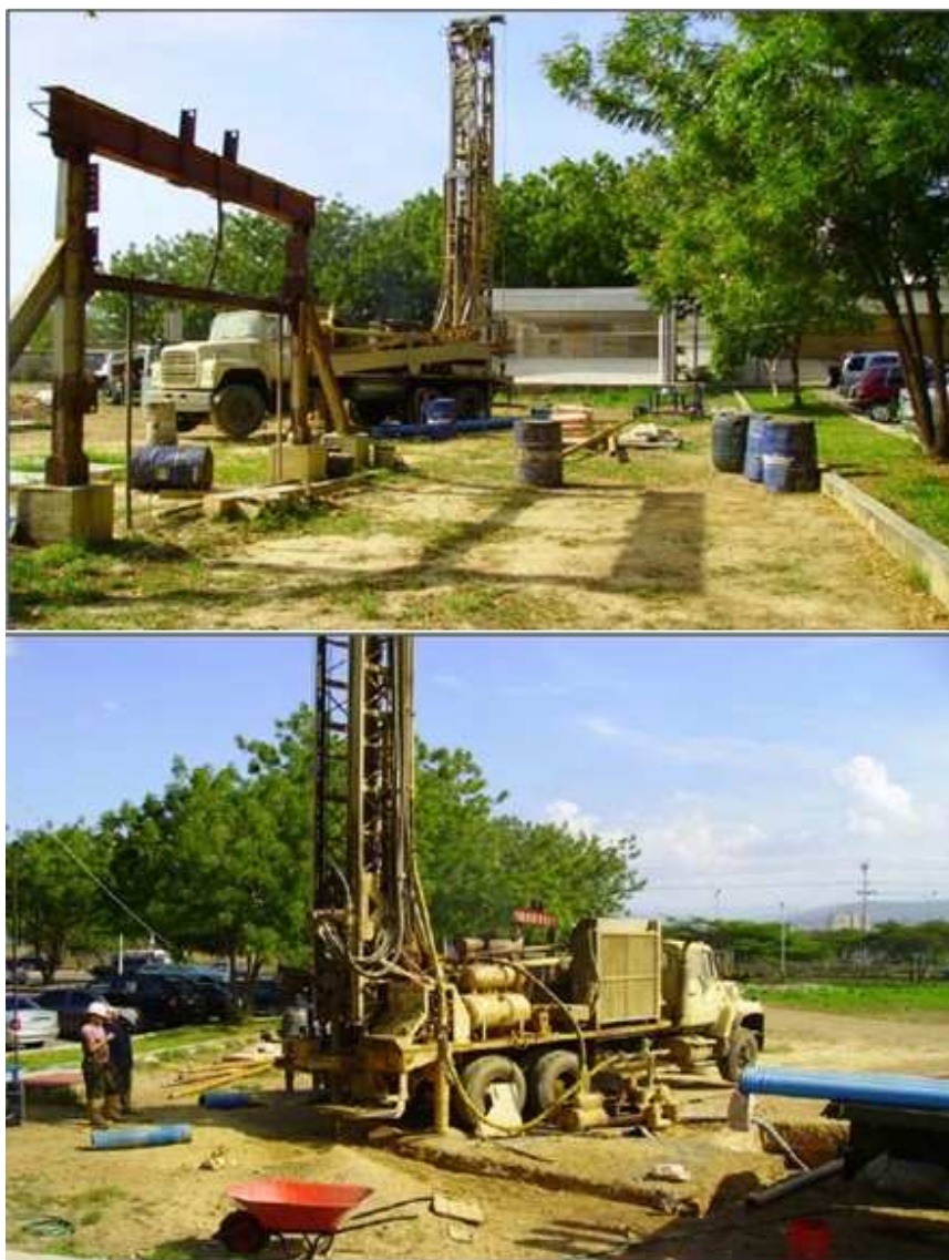
Figura A19. Vistas de la ejecución de la perforación del pozo 3. Tomado de GISCA (2006).
