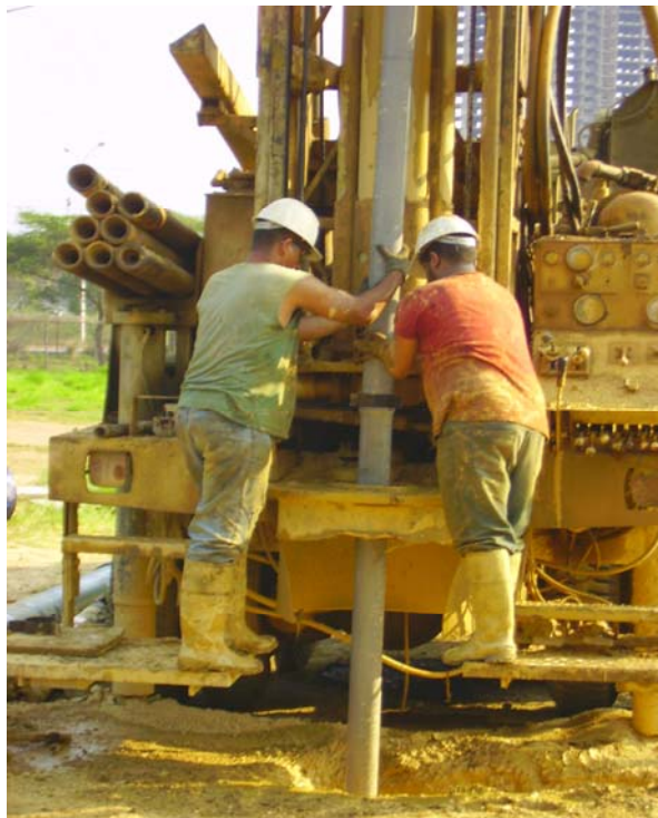
Figura 14: Vista general del proceso de entubado.
