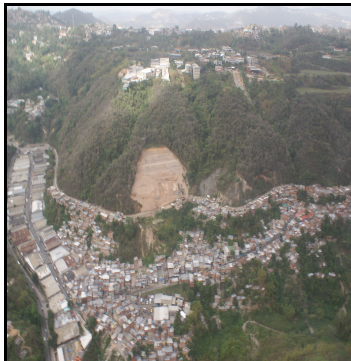
Foto N° 13: Fotografía aérea del talud (donada por el Profesor Feliciano De Santis)
