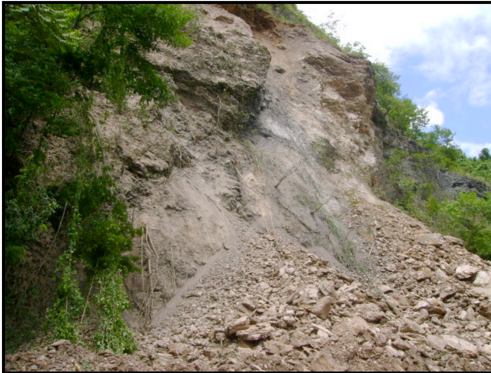
Foto N° 16. Vista de perfil del talud MD2, donde se tiene una sección de rotura en cuña.
