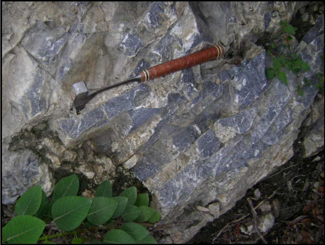
Foto N° 21. Planos de discontinuidad de los marmoles existente en esta estacion.
