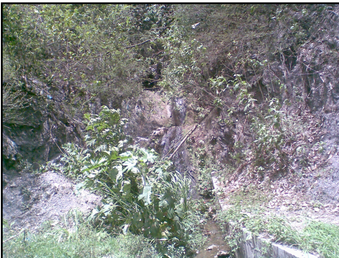
Foto N° 19. Sector estable desde el punto de vista cinemático, debido a que la geometría de las discontinuidades favorece la estabilidad.
