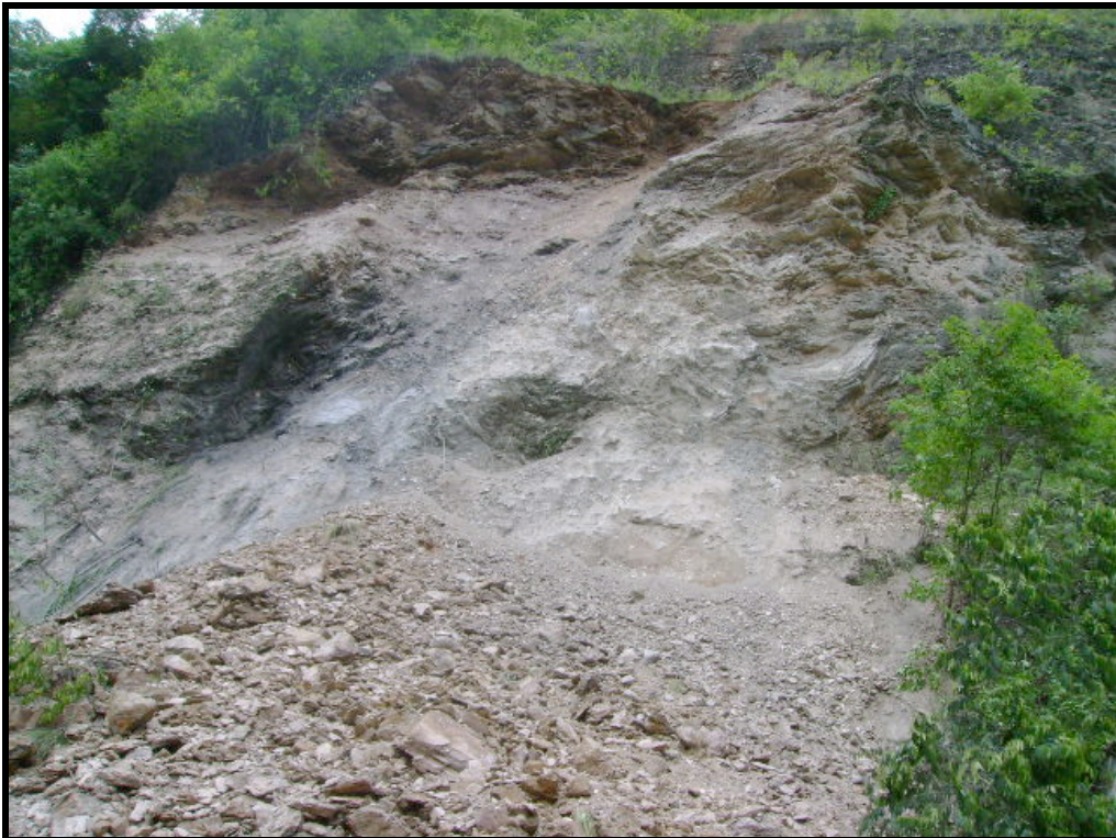
Foto N° 15. Se muestra el material colapsado y la rotura en cuña en el talud.
