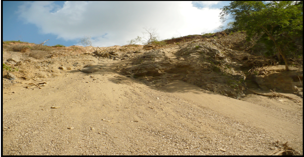
Foto N° 26. Vista frontal del derrubio de detritos colapsando en el talud.
