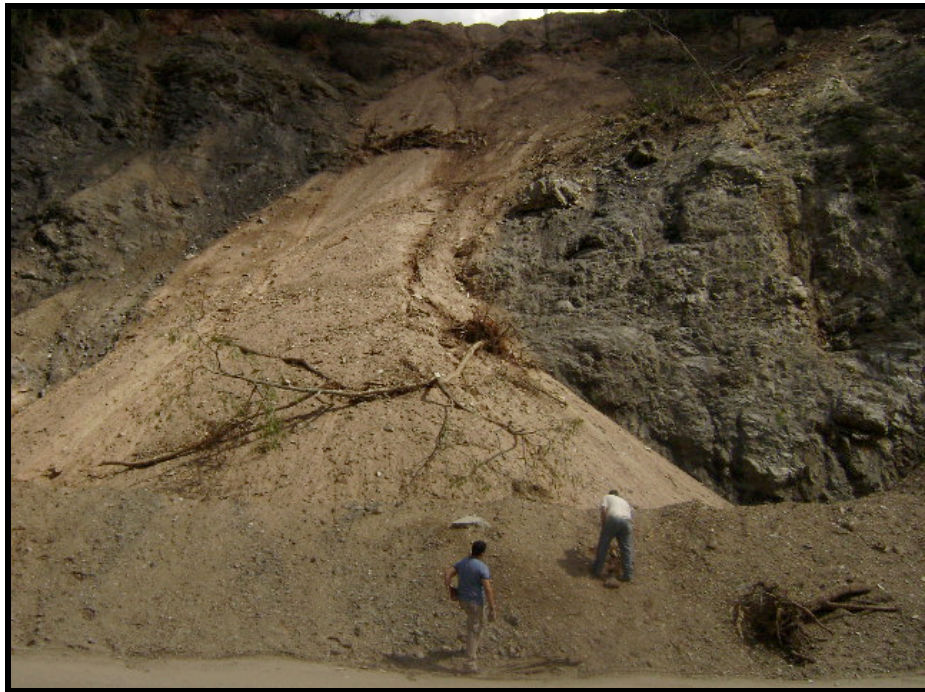
Foto N° 24. Vista del movimiento en masa presente en el talud.
