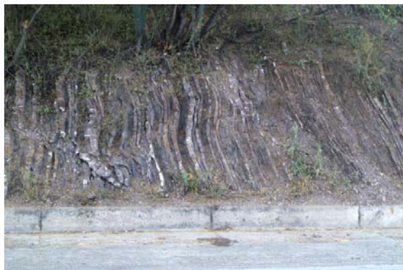
Fig.C66. Secuencia de arenisca y lutita, Formación Matatere III. Puente Torres. Carretera vieja Carora Barquisimeto. La-1329
