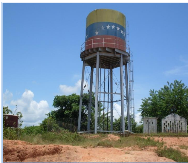
Figura 36. Tanque elevado. Ubicado en el sector Bolivariano.
