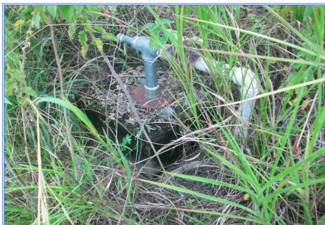
Figura 37. Pozo sellado ubicado en el sector Oripopo
