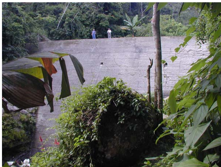
Figura 2 Dique Uraca PCH Choroní. Fuente Propia
