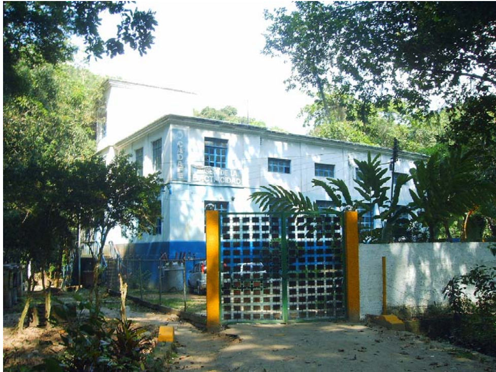
Figura 4 Vista externa de la casa de máquinas. Fuente Propia
