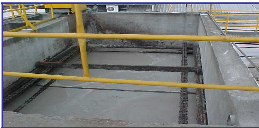
Ilustración N° III-10. Silo para grasa.
