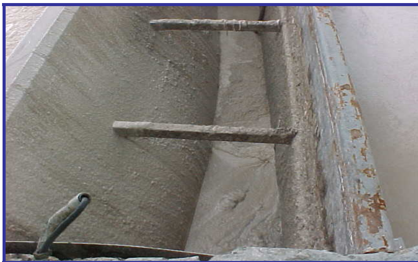
Ilustración N° III-11. Fosa para Desnatado.
