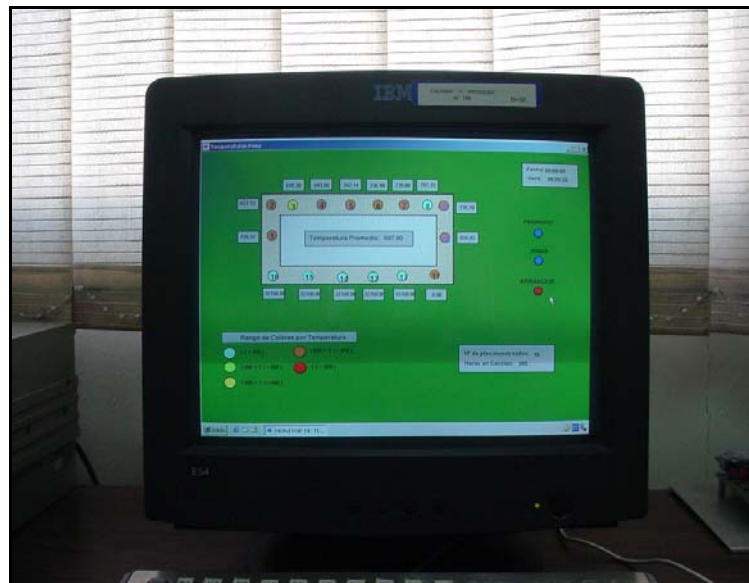
Figura 3.6 Visualización de la distribución de termocuplas en el monitor.
