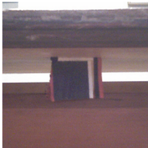
Figura 9.7. Amortiguador de goma de foaming.
