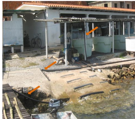
Figura 4. Tuberías de PVC que transportan el agua.
