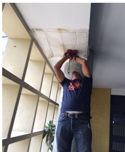
Figura 4.19 Ferroskan Sondeo Con Radiografía Viga Escalera
