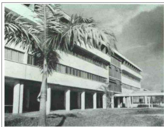
Figura 2.1 Fachada Sur Edificios de Residencias ETI
