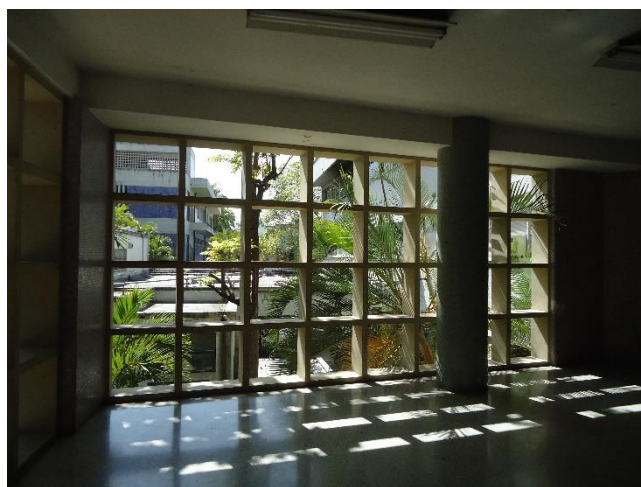
Figura 4.16. Pasillo de Entrada Piso 1 Columnas con mosaico y vigas friso en buen estado
