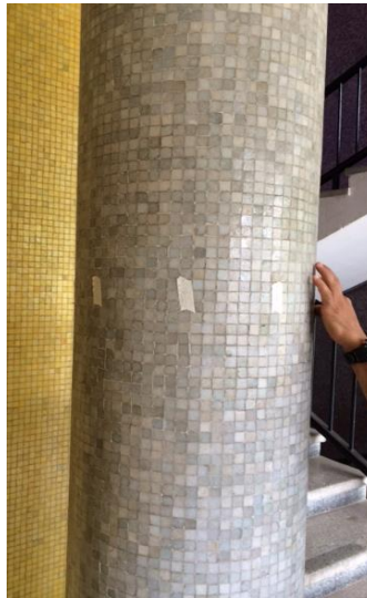
Figura 4.21 Separación de Acero Longitudinal hecho Con Ferroskan
