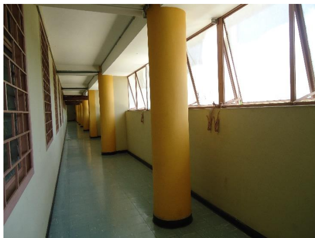
Figura 4.17. Pasillo de Piso 2. Columnas y vigas friso en buen estado
