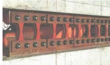
Fig. 8. Dispositivo Honeycomb. Fuente: antisismos.blogspot.com
