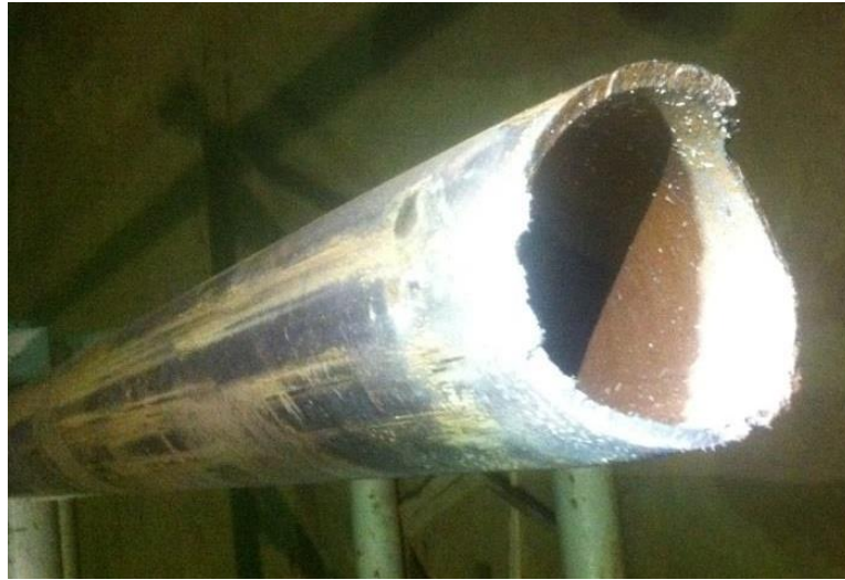
Figura 37. Tubería que falló durante viaje a superficie en backreaming B-03
