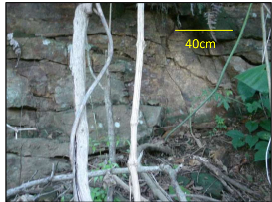
Figura D.2. Afloramiento del gneis de La Aguadita (NPlad) muy fracturado e intervenido por la vegetación.
