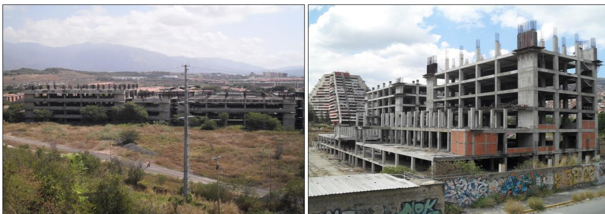
Hasta la fecha, las obras del oncológico de Guaremas (izq) ni del Instituto Nacional del Cáncer (der) han sido culminadas / Fotos: Manuel Alegría ( Diario La Razón, 2015 )
