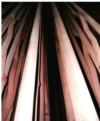
Figura 46. Tubos del sobrecalentador BL-61-1. (Marzo 2006)
