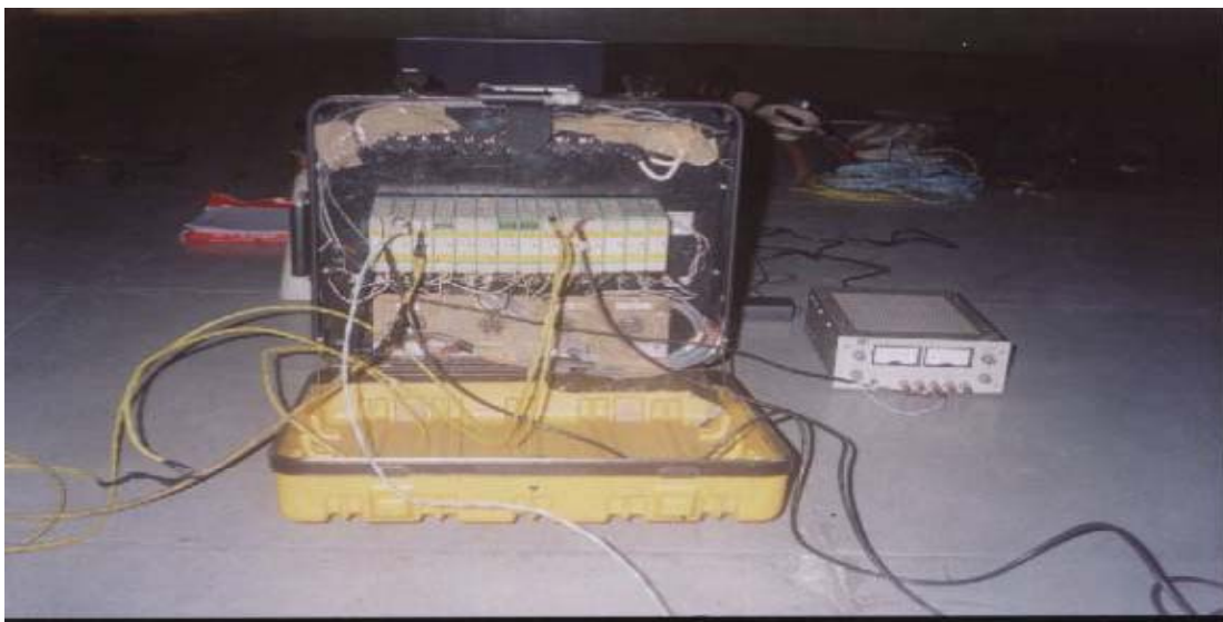
Fotografía 3.4 Conexión a la caja de mediciones donde se encuentran los amplificadores operacionales.
