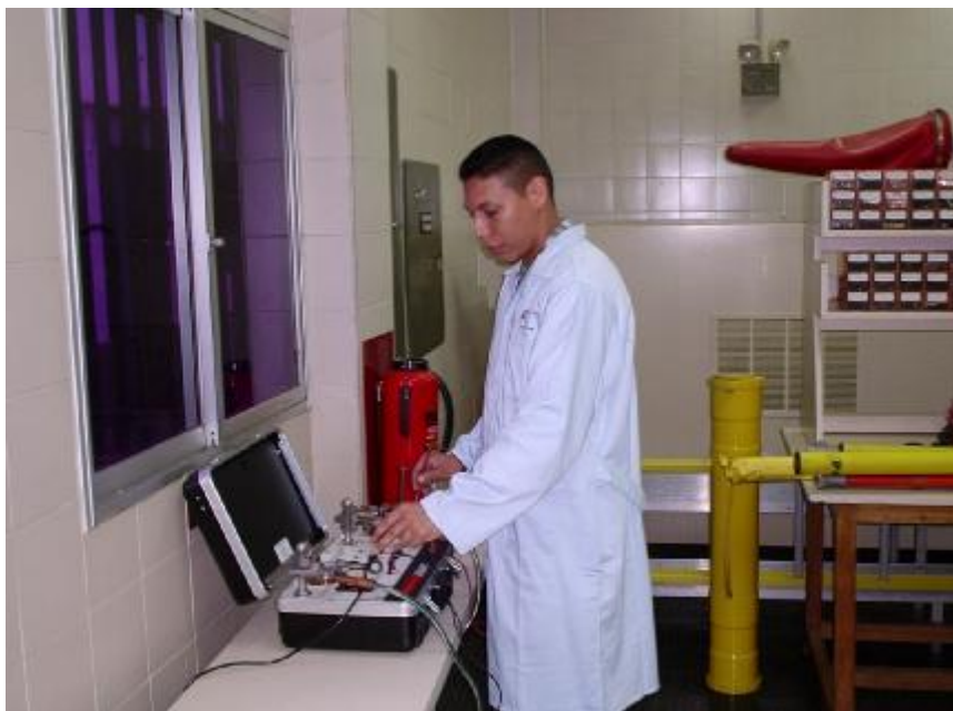
Figura 6.6. Prueba de medición de resistencia sobre el puente de la A.B. CHANCE.
