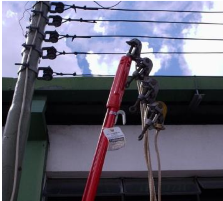
Figura 8. Forma de instalación desde el suelo o el poste del arreglo en cascada.
