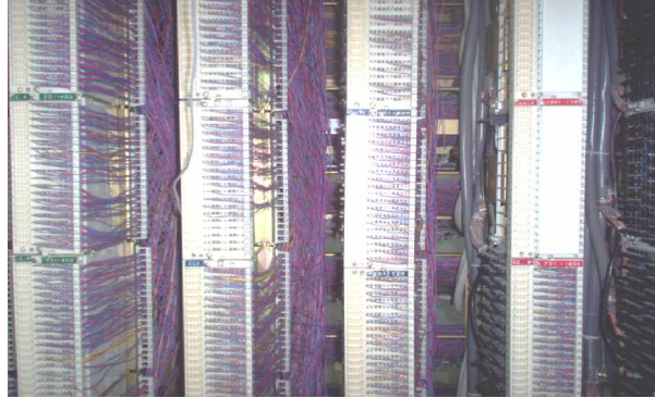
Figura 3 Distribuidor Principal
