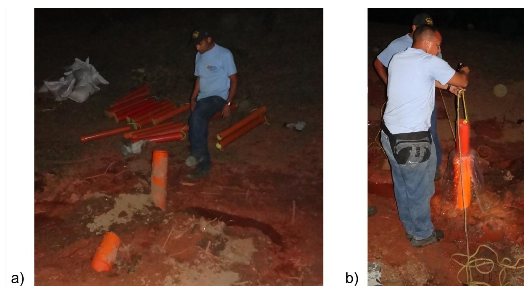
Figura 4.6. Carga de explosivos a cargo del personal de CAVIM. a) Anfo (bolsas blancas) y Pentolite (cilindros naranja), b) Carga de explosivos.
