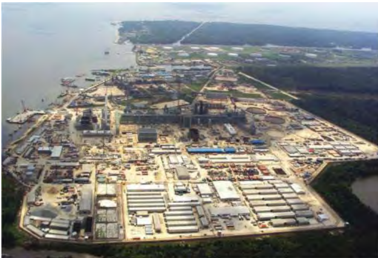
Figura 1.2: Sasol Escravos GTL en construcción, año 2010. [11]
