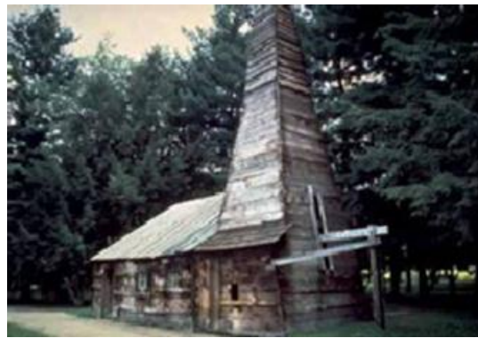
Figura 1. Pozo de gas natural en el Lago Erie, EE.UU. [5]
