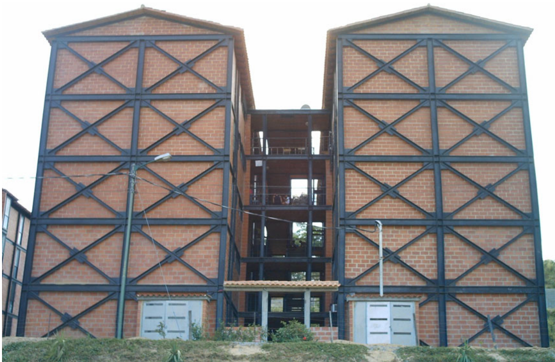
Lateral del edificio. Se aprecia el área de circulación de las dos torres, el techo en dos vertientes y los arriostramientos.
