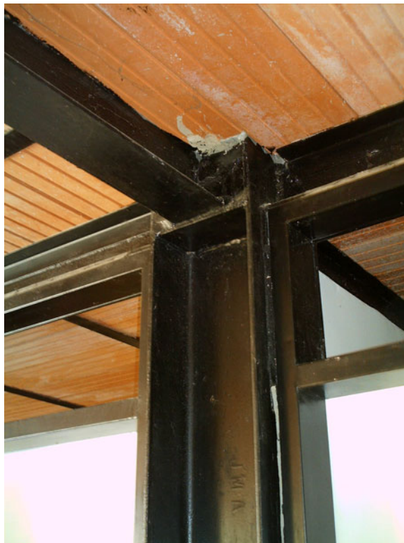
Interacción entre vigas y columnas de perfiles Doble “T” con la tabiquería y puertas internas
