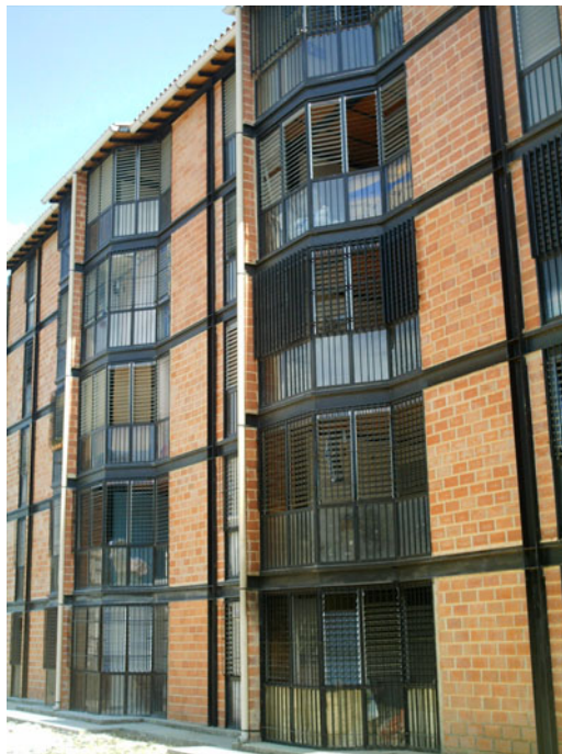
Balcones de la estructura
