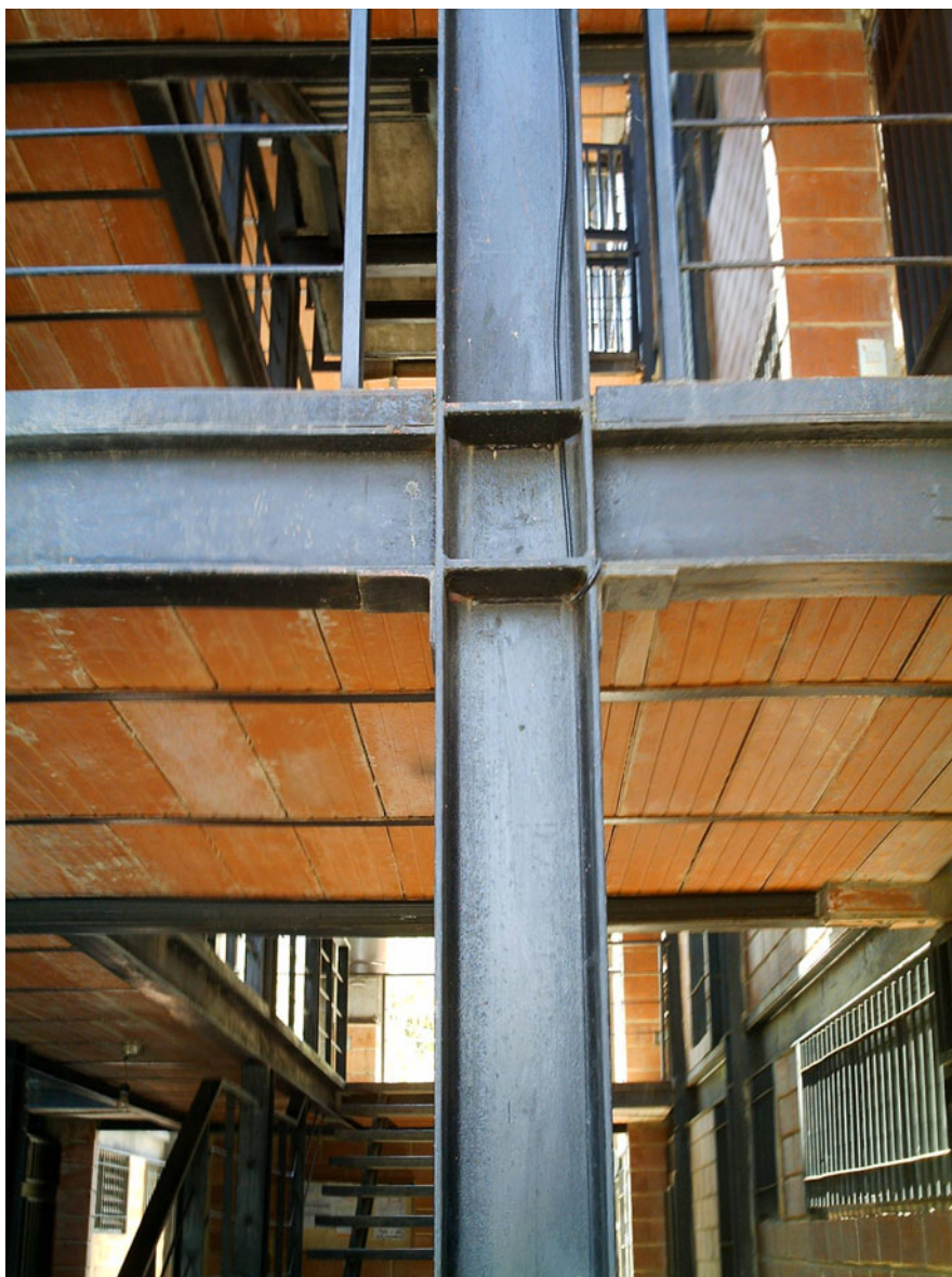
Conexión entre vigas y columnas de perfiles Doble “T” del área de circulación
