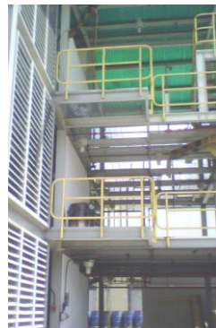
Figura 5.11 Barandas de la estructura Noroeste 3
