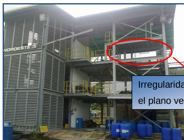
Figura 4.19 Irregularidad en el arriostramiento.
