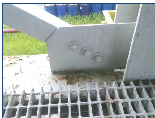
Figura 4.14 Conexión de una diagonal de la estructura.
