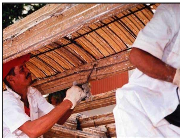
Ilustración IV- 19. Colocación de Bovedillas.
