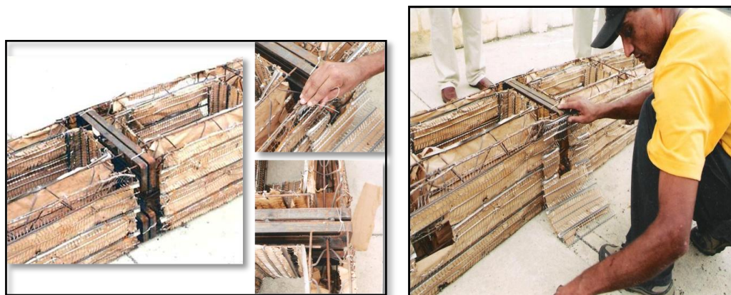
Ilustración IV- 13. Unión de Vigas de Cargas.
