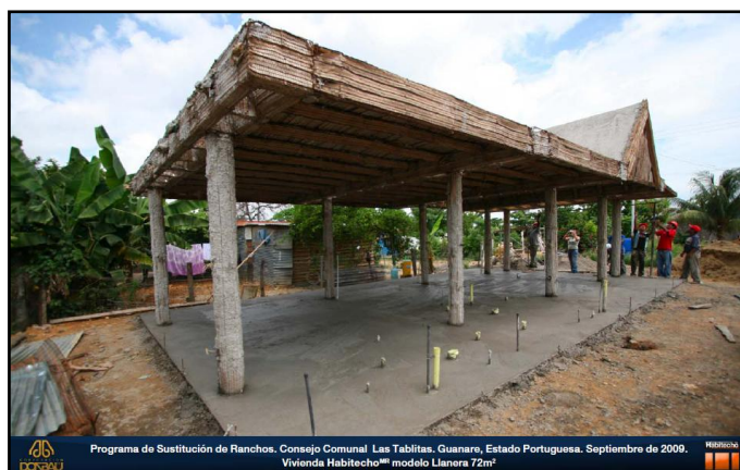
Ilustración II - 4. Malla Zen-Zen y vaciado de concreto.
