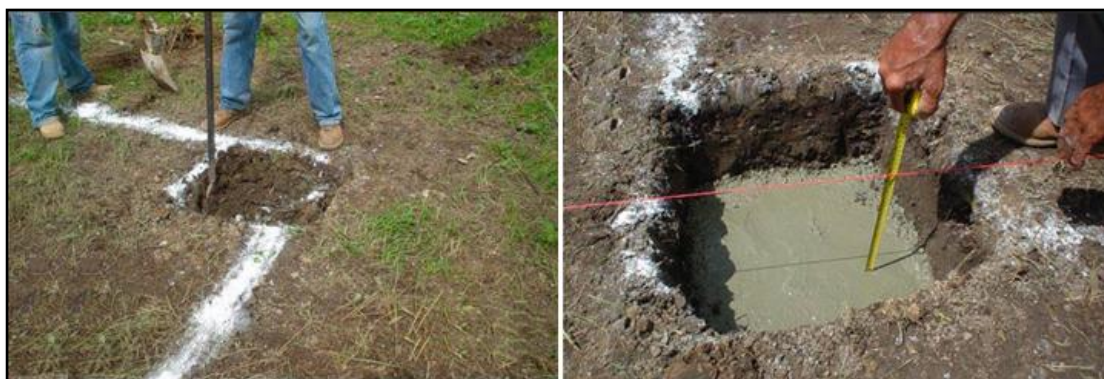
Ilustración IV- 10. Preparación del terreno.
