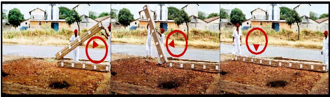
Ilustración IV- 12. Colocación de vigas de Carga en Sitio.
