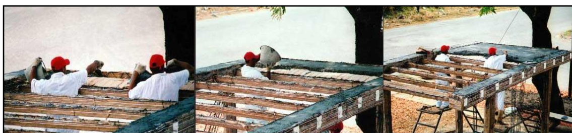
Ilustración IV- 18. Vaciado de Vigas de Cargas.
