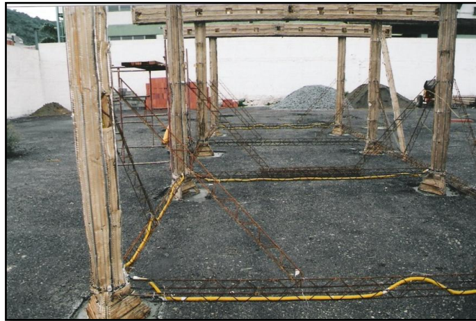
Ilustración IV- 15. Vista de vigas y Columnas Armadas.
