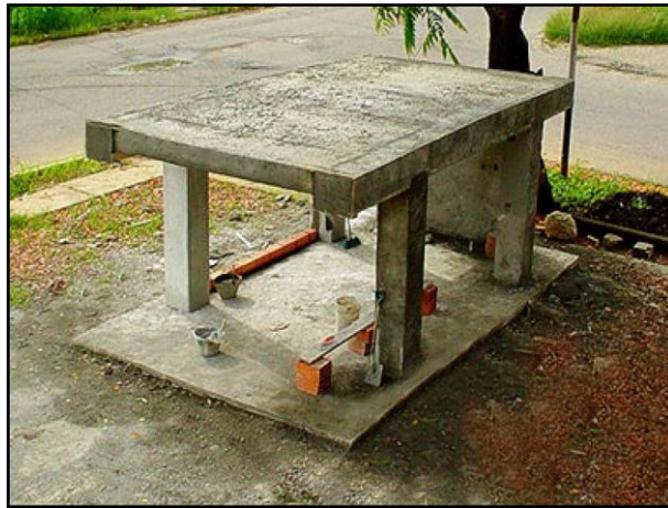
Ilustración IV- 22. Vista de Acabado de Techo y Columnas.
