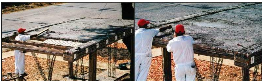
Ilustración IV- 20. Vaciado de Bovedillas.
