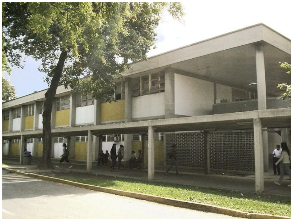
Figura 7: Fotografía de la edificación.
