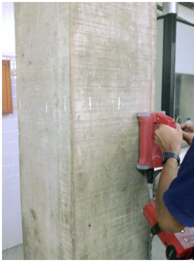
Figura 14. Operador realizando detección rápida en columna
