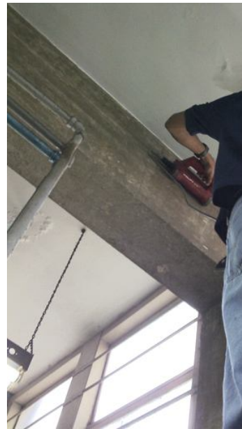
Figura 15. Operador realizando detección rápida en viga
