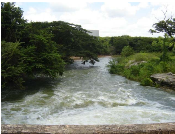
Imagen26 Canal de descarga hacia el Río Pao
