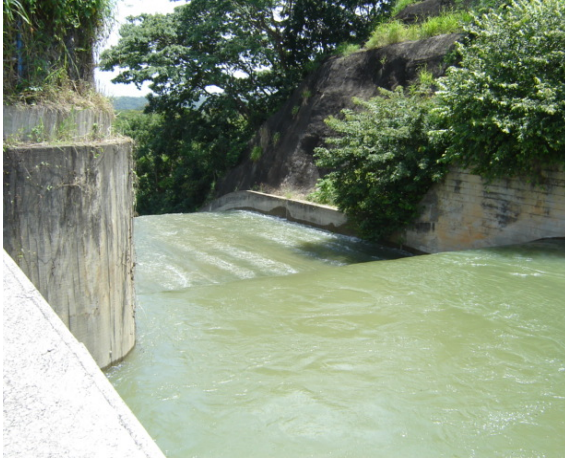
Imagen21 Cimacio del aliviadero (vista desde aguas arriba hacia aguas abajo)
