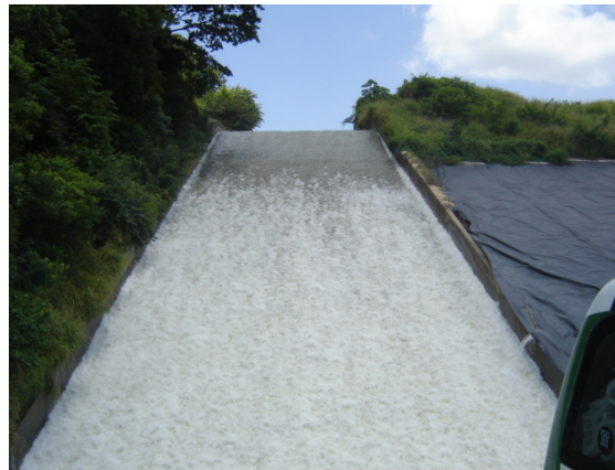
Imagen24 Rápido del Aliviadero descargando
