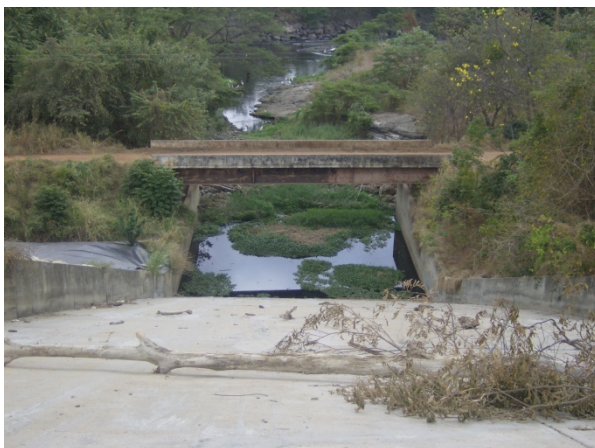
Imagen25 Pozo disipador del aliviadero
