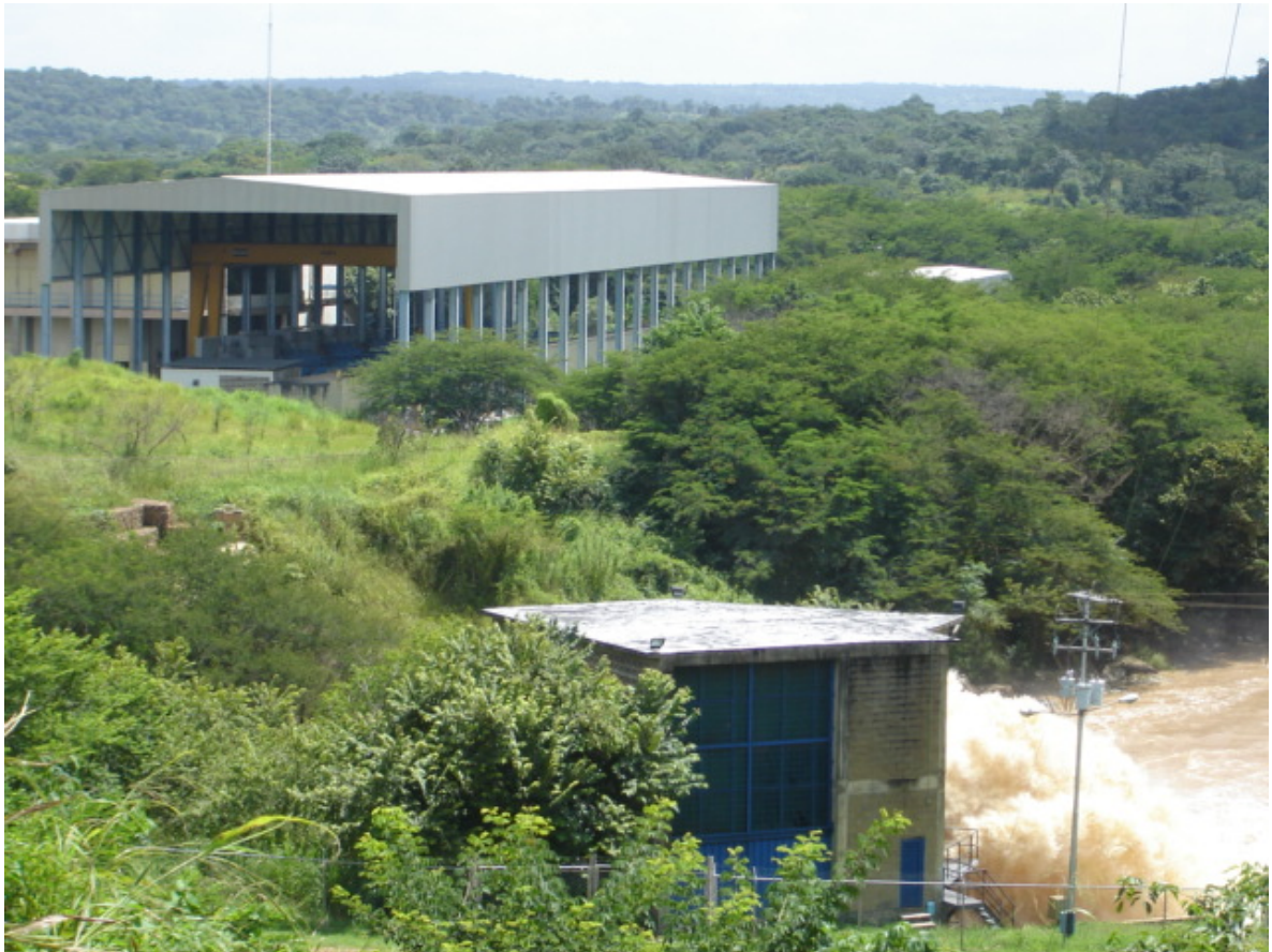
Imagen 32 Estación de Bombeo Pao 1 (esquina superior izquierda). Sala de Válvulas de Embalse Pao - La Balsa (esquina inferior derecha).
