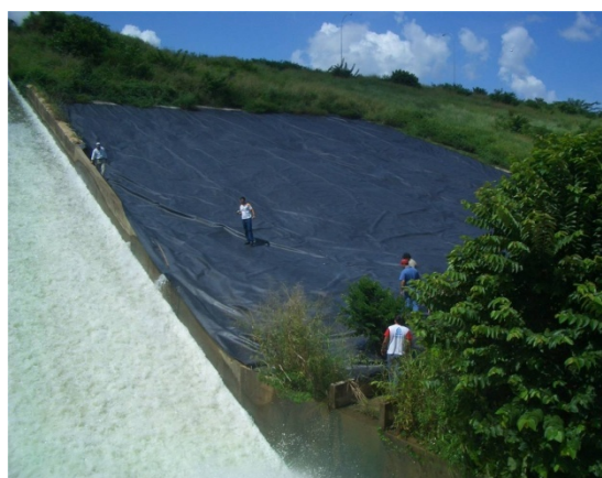
Imagen34 Manta de protección del talud aguas abajo de la Presa Pao - La Balsa.
