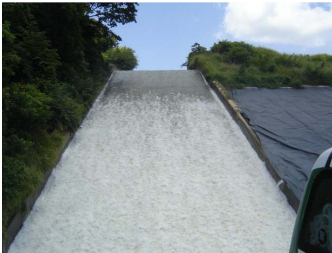
Imagen3 Aliviadero actual del Embalse Pao - La Balsa. Vista frontal
