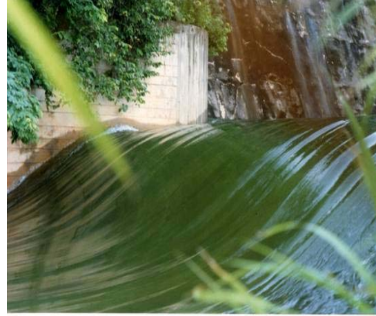
Imagen22 Cimacio de aliviadero (vista desde aguas abajo hacia aguas arriba)
