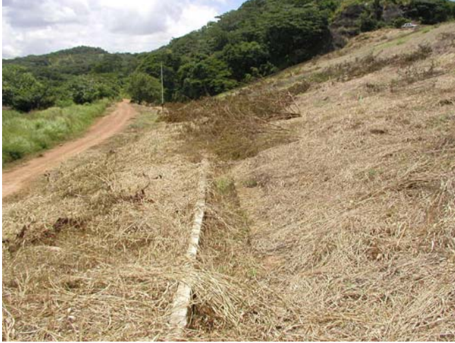
Imagen 31 Carretera de acceso a Embalse Pao - La Balsa y estación de bombeo Pao 1.
