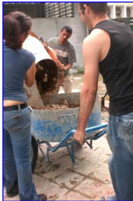
Foto III.14 Descarga del Trompo al recipiente
