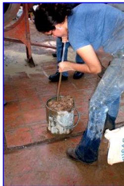
Foto III.21 Compactación de la Mezcla
