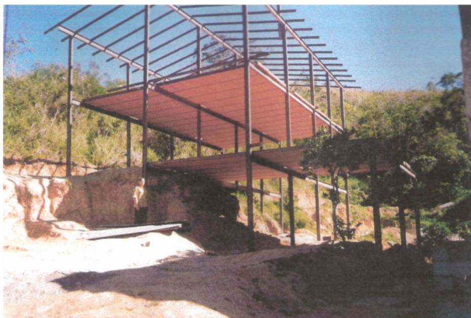
Figura II.4 - Foto Antigua del Estado de la Estructura.
