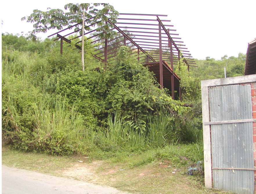
Figura II.5 - Foto Estado Actual de la Estructura.
