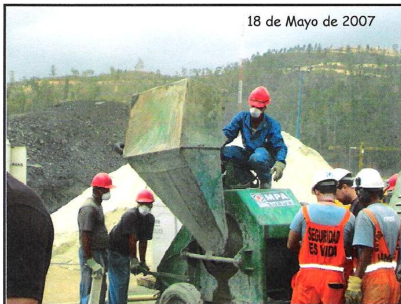
Foto 2: Elaboración de la mezcla de Concreto con Fibras Para realización de Bandejas con Fibra Dramix
