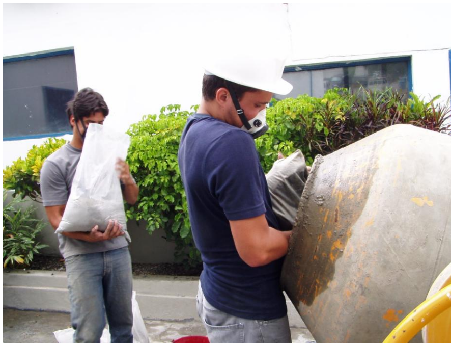
IMAGEN #20 Introducción del Cemento.
