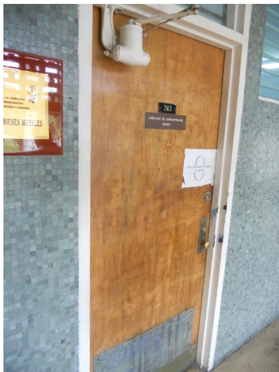
Anexo 12: Puerta con sistema de retorno automático ubicada en el Departamento de compra de bienes y muebles. Piso 2
