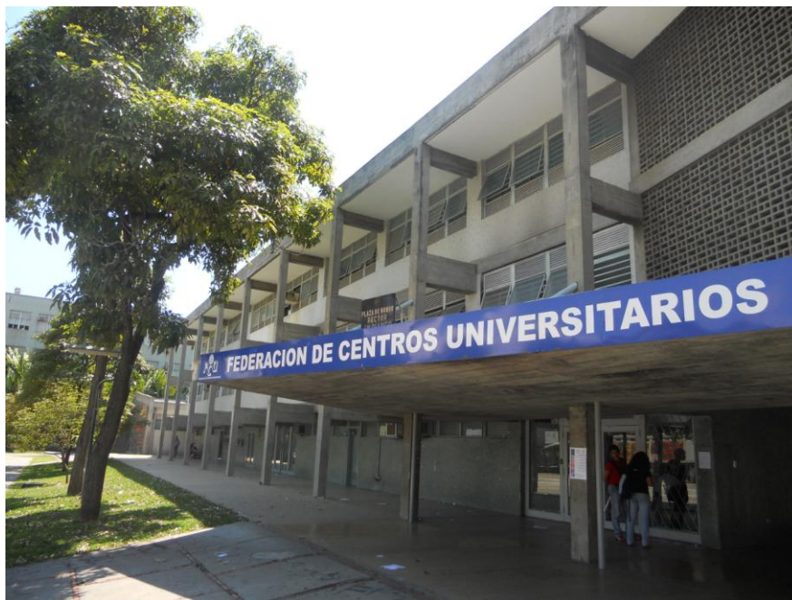
Figura 4. 1 Edificio de Comunicaciones FUENTE PROPIA
