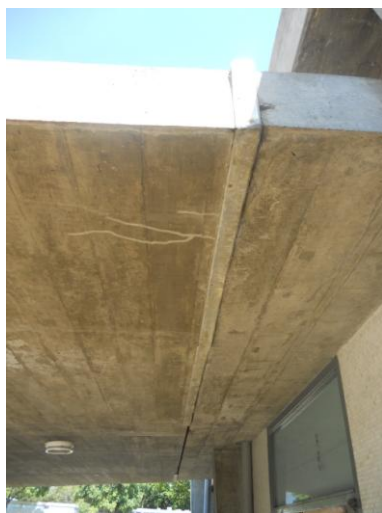
Figura 5. 11: Junta de Construcción.
