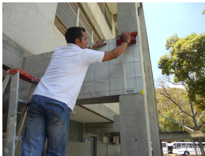
Figura 4. 18: Sondeo con Radiografía FUENTE PROPIA
