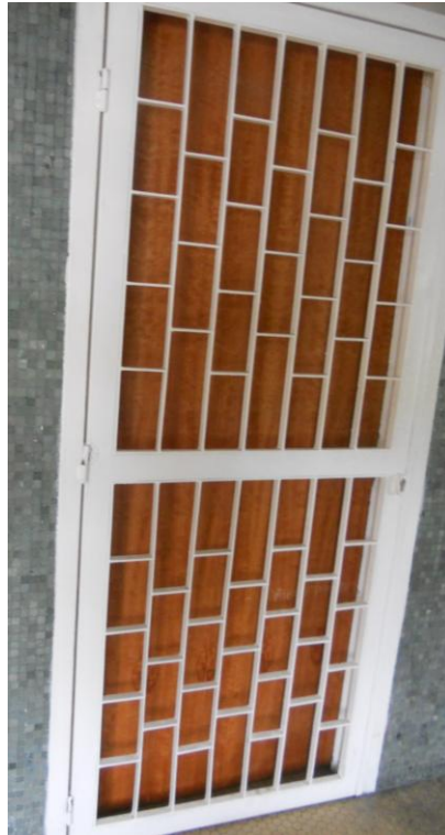
Anexo 24: Puerta de madera. Ubicada en el Piso 1
