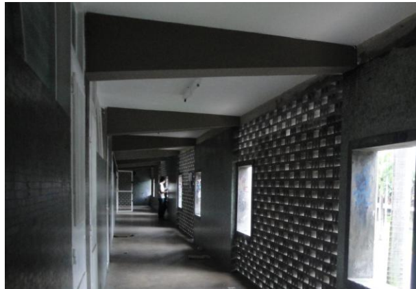
Figura 4. 7: Variación en Sección Transversal. Pasillo Piso 1 FUENTE: PROPIA
