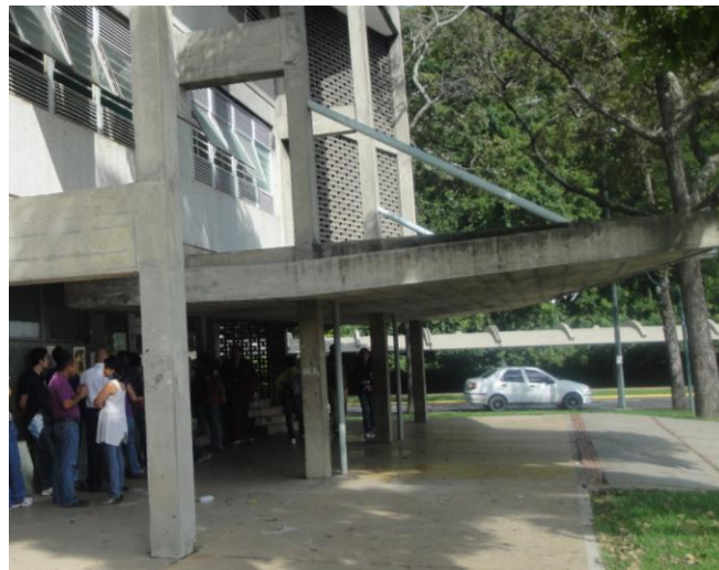
Figura 4. 9: Elemento Tensor en Viga Transversal construido
