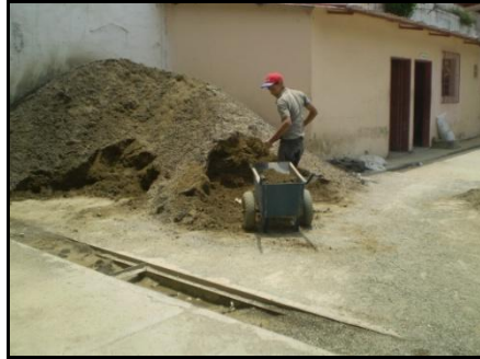
Imagen 5: Dosificación del agregado
