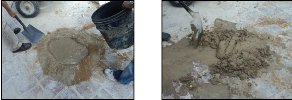
Imagen 25: Preparación del mortero
