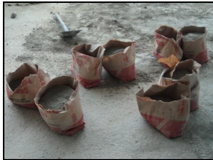
Imagen 32: Dosificación del cemento
