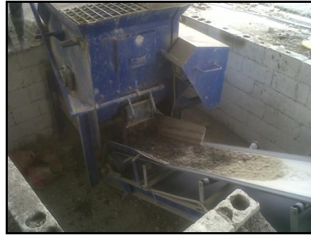
Imagen 8: Traslado de la mezcla mediante la cinta transportadora
