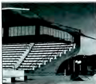
Figura 8/ Paso cubierto acceso norte desde la Plaza Venezuela.
